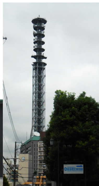
〈防衛省通信タワー〉
